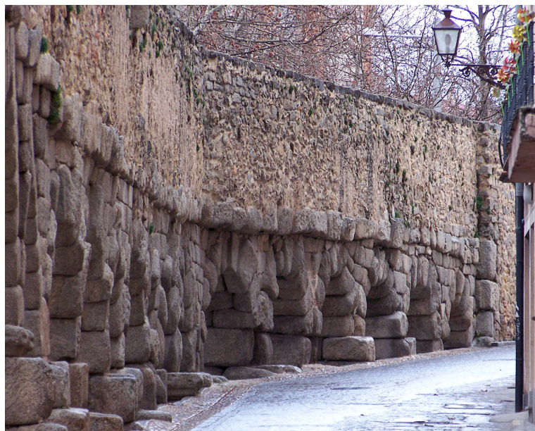
Fig. 4. Acueducto de Segovia, primeros arcos.
